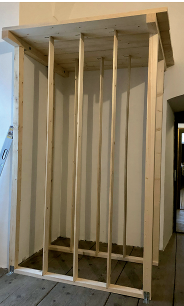
Abb. 9: Depotkonstruktion für großformatige Kreuzwegstationen mit begehbarem Gang an der Rückseite. Karmelitenkonvent Linz (Foto: Barabas)
