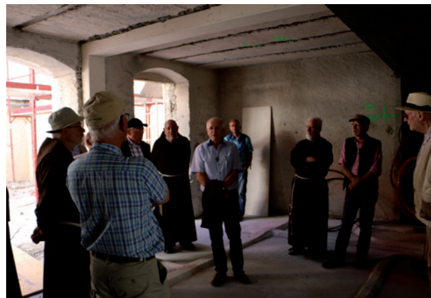
Abb. 5: Baustellenbesuch im ehemaligen Kapuzinerhospiz Ried im Oberinntal (Foto: Kapuzinerprovinz Österreich-Südtirol).
